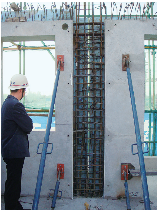
图4 剪力墙结构外挂板施工安装
