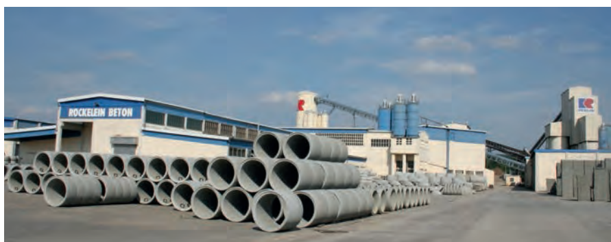
Röckelein 在新的循环厂房生产格构梁板, 厂房位于 Rattelsdorf Ebing 工厂, 由 Ebawe 和 Progress 公司提供。到目前为止, 工厂主要生产地下工程产品, 特别是混凝土管道
