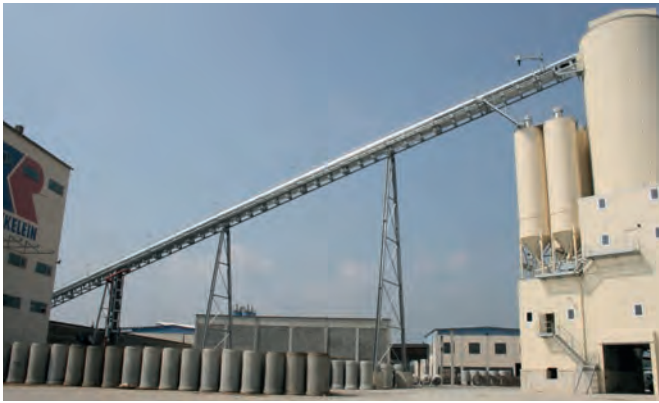
原料由 120 米长的传送带直接从采砾场运到搅拌楼储料仓
