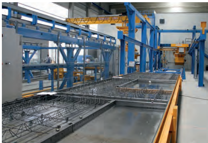
安装完钢筋的模板托盘在去混凝土浇筑站的路上
