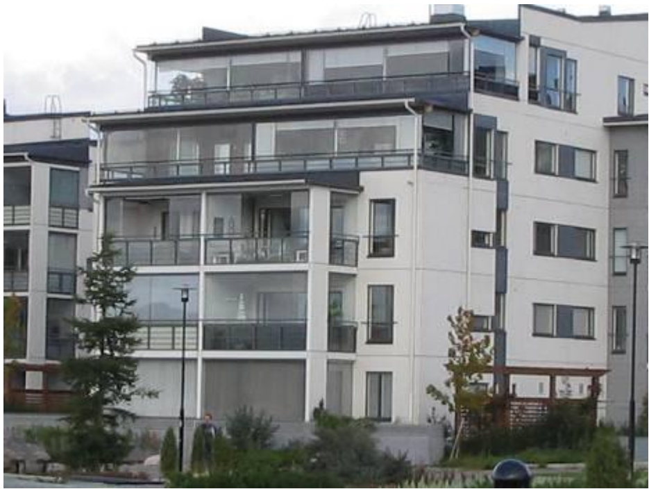
图 20. 芬兰街景-白色水洗石预制外墙版
