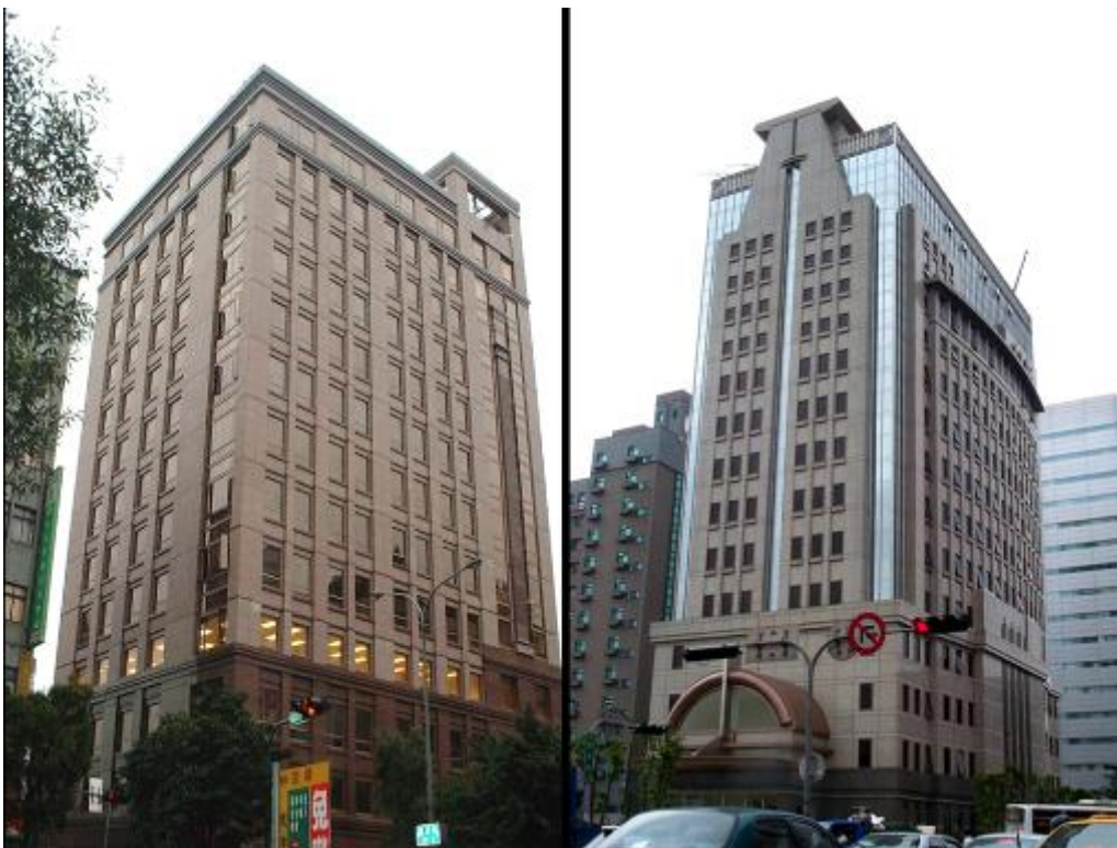
图 18. 石材 PC 外墙商业大楼
