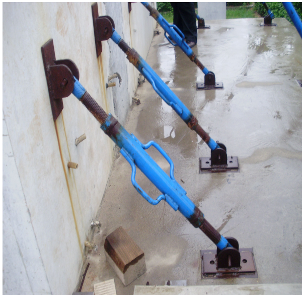
图 25 墙板支撑系统
