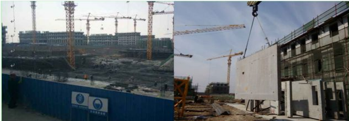
图1 惠生新城施工现场图片
