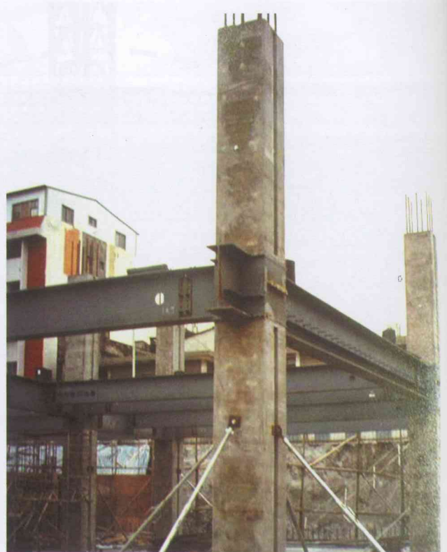
图12 台湾台北听障奥运场馆预制与屋顶钢构施工现场
