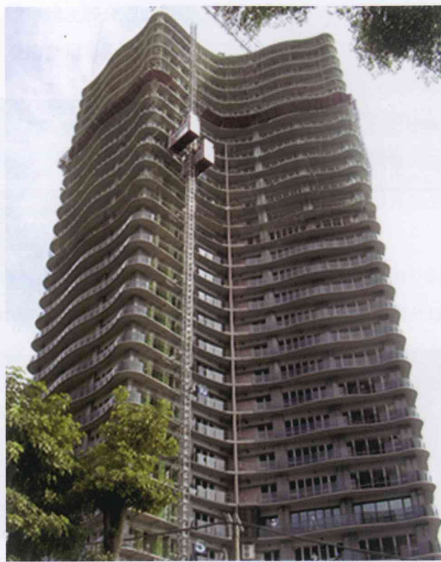
图 7 预制施工外围无脚手架及弧形阳台板
