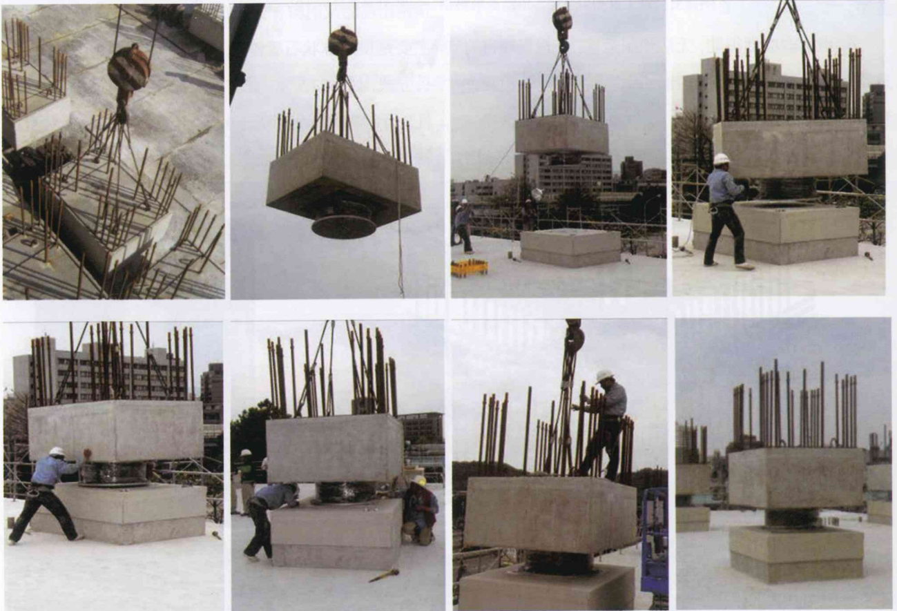
图 24 改良式半预制隔震工法
