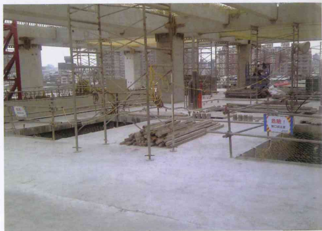
图 19 台湾台北地政大楼预制施工现场
