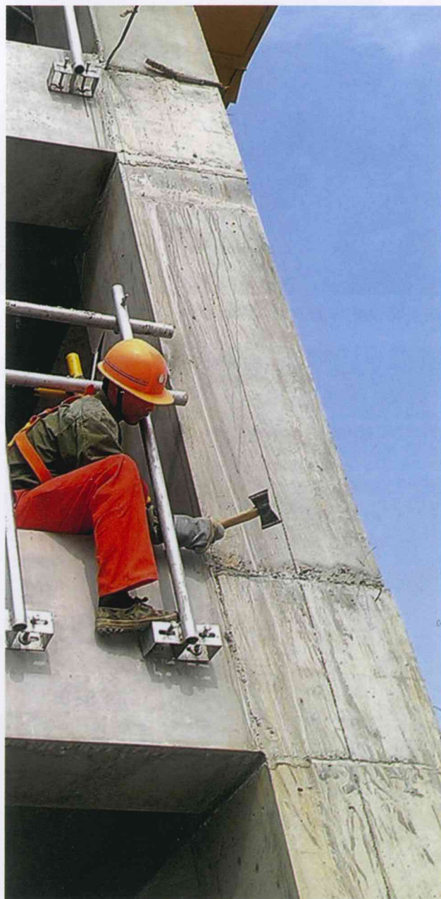
图3 现浇混凝土外观质量
