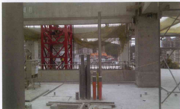
图 27 台湾中和地政大楼采用垂直干管先行于楼板灌浆预埋
