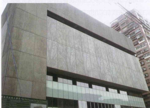
图 15 台湾台北中和地政大楼的树影造型预制外墙板
