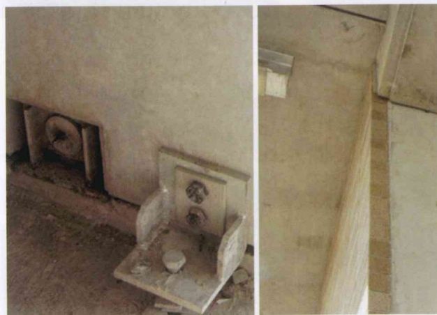
图 18 上海预制装配式建筑研发中心城建海港基地2号试点楼夹芯保温预制外墙板现场
