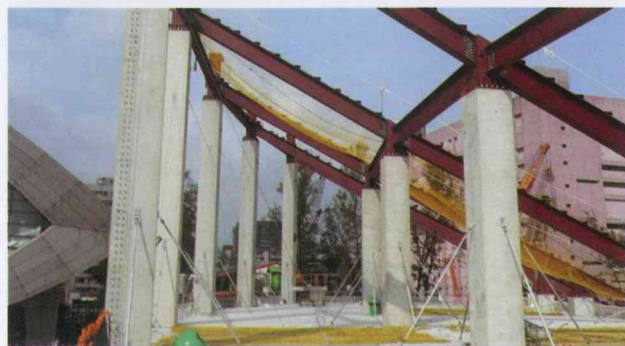
图11 台湾台中物流钢构与预制节点
