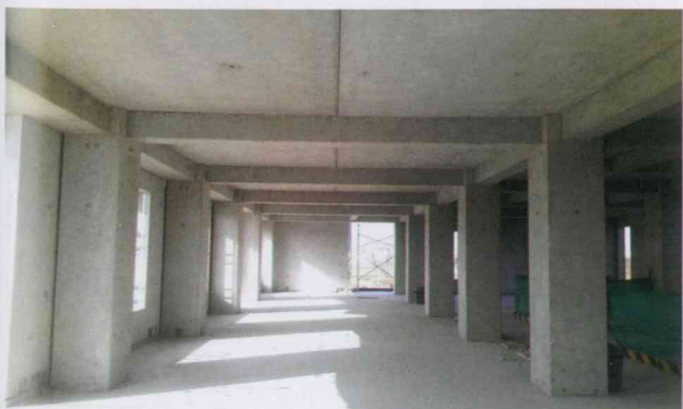
图2 预制混凝土外观质量
