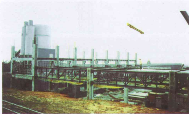
图10 台湾杨梅纺三厂施工现场
