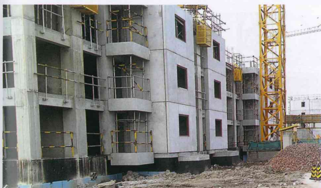
图1 现浇混凝土与预制混凝土外观质量的比较
