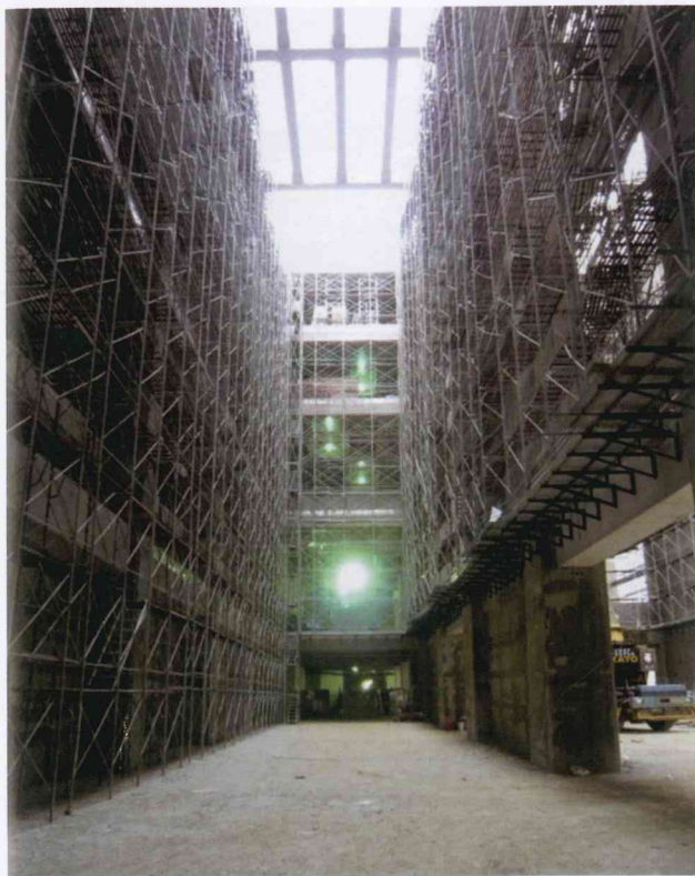
图 6 预制挑高施工室内无支撑施工
