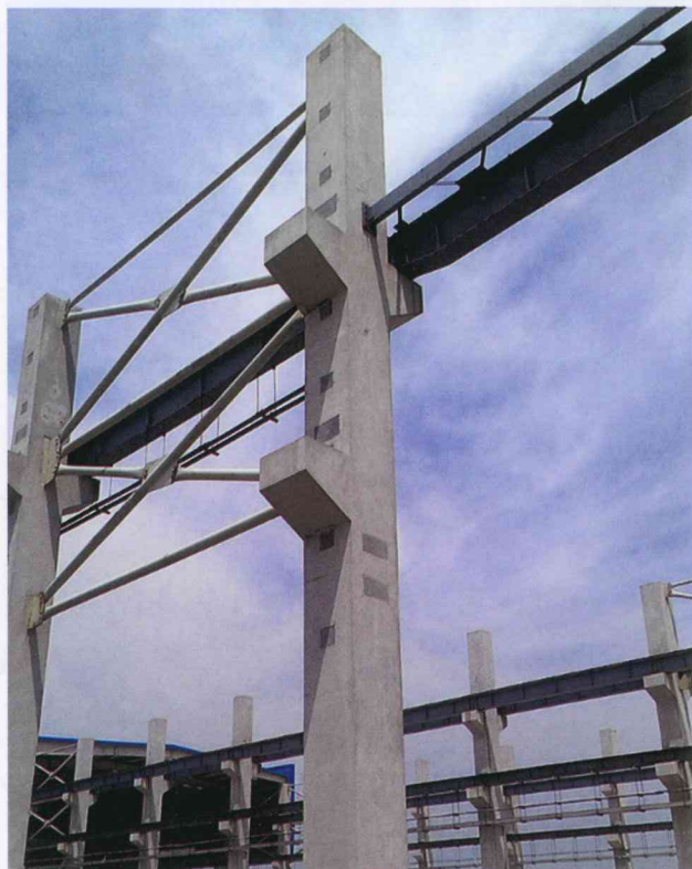
图4 预制长柱一体浇筑的质量确保
