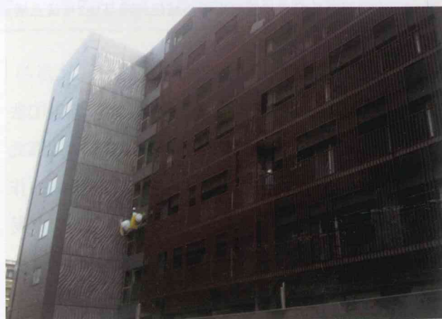
图 16 台湾台北中研院学人宿舍的波纹造型预制外墙板
