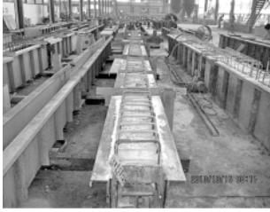
图3 梁模混凝土浇筑
