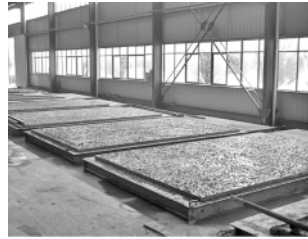
图4 板模混凝土浇筑
