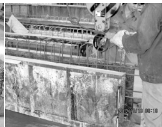
图8 钢筋骨架入模
