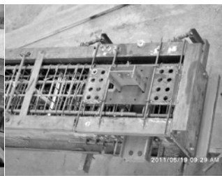
图6 型钢连接件入模
