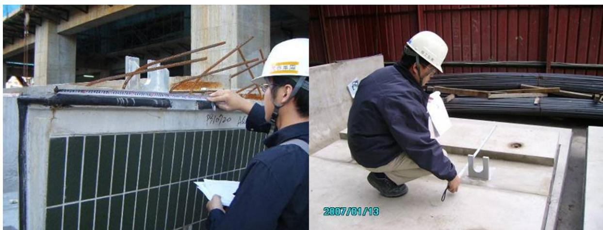
图 20 进货检查：1. 墙版成品尺寸 2. 墙版预埋铁件位置 3. 水电预留孔位置及大小 4. 预嵌窗位置 5. 防水胶条位置
