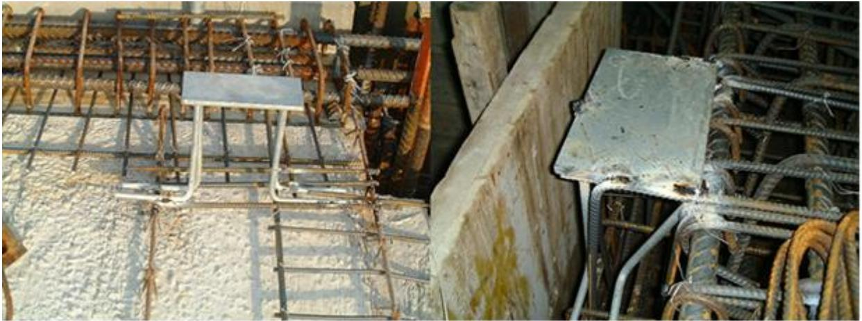
图 17 躯体铁件预埋及电焊固定
