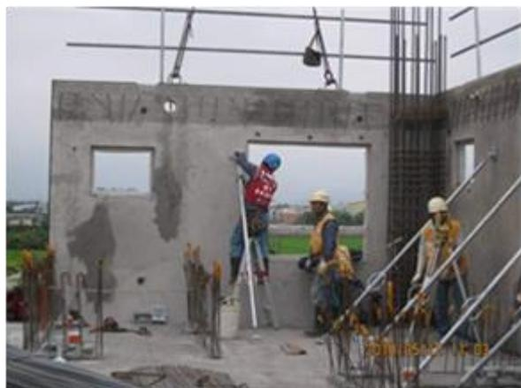
图 37 湿式 PC 外墙版斜撑安装与调整
