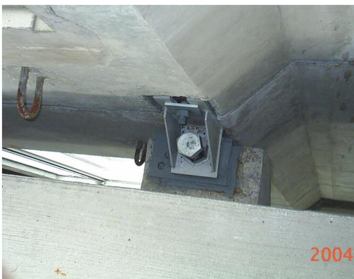
图 27 铁件防锈漆涂装
