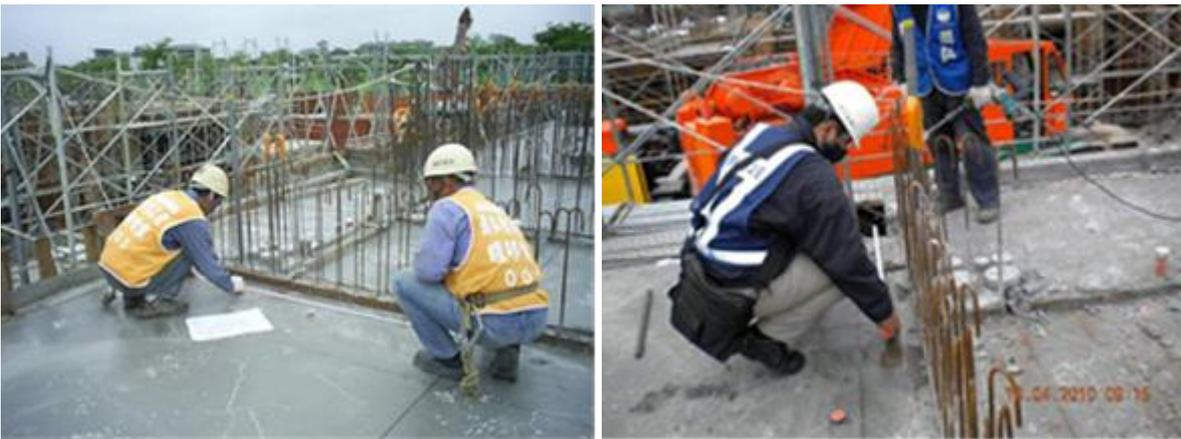
图 33 湿式 PC 外墙版分割线放样及样线检查
