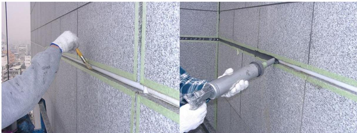
图 30 外墙耐候性防水胶施打
