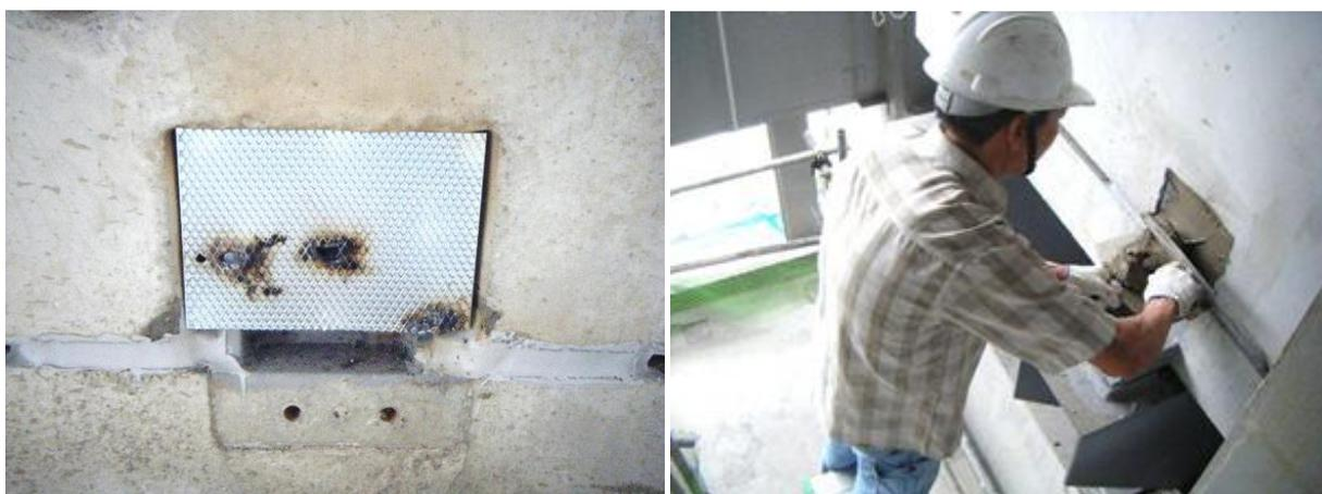
图 31 收尾工作—防护铁网及泥做粉刷
