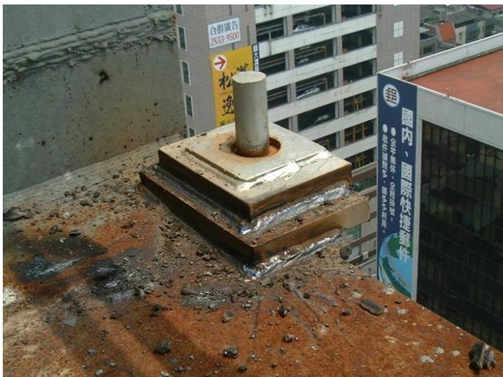
图 19 结构体躯体铁件误差修正
