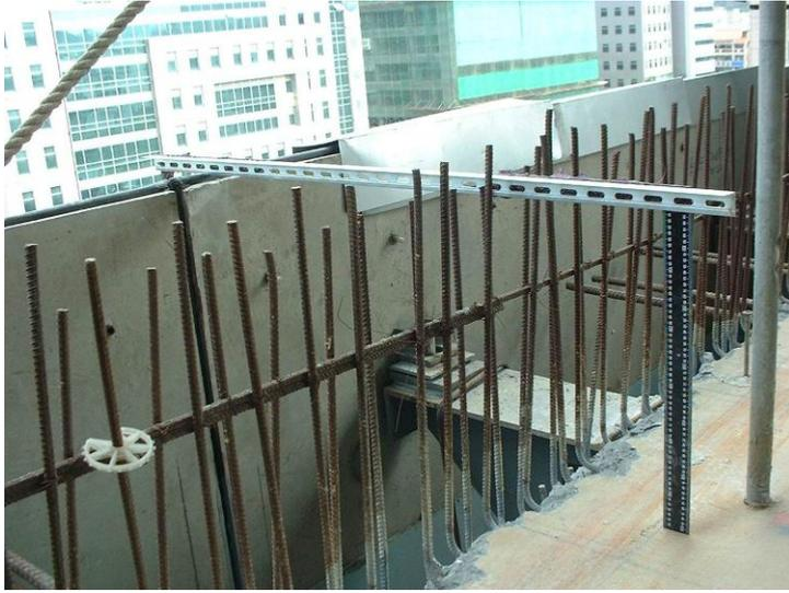
图 16 利用延长角尺量测垂直控制线
