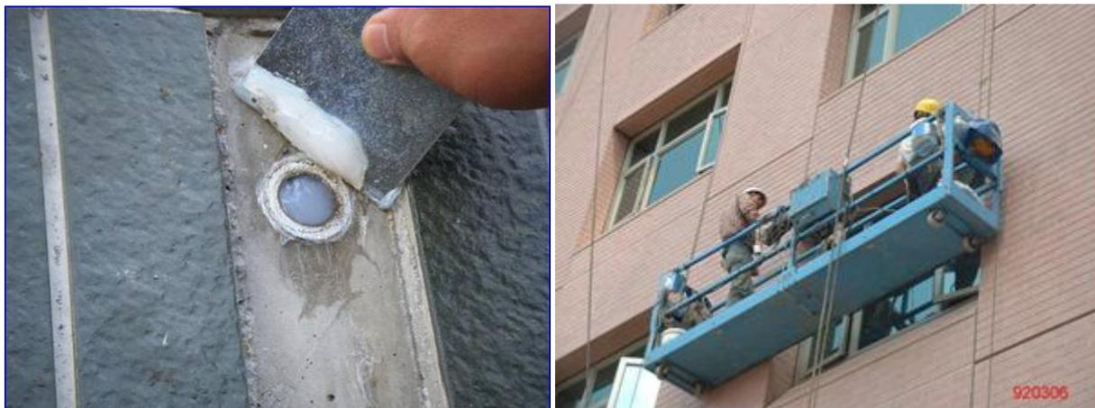
图 29 面饰材修补前需将吊点先以硅酮填塞
