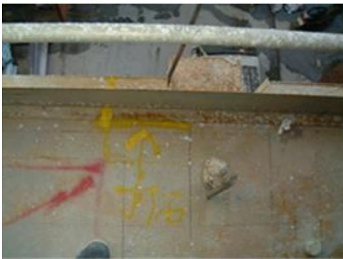
图 18 躯体铁件误差修正
