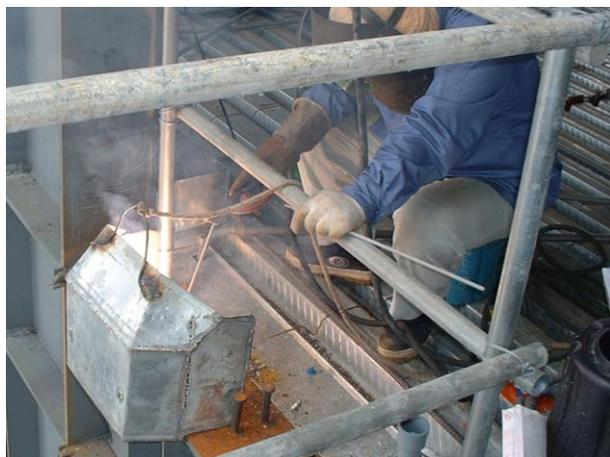
图 21 结合铁件安装电焊
