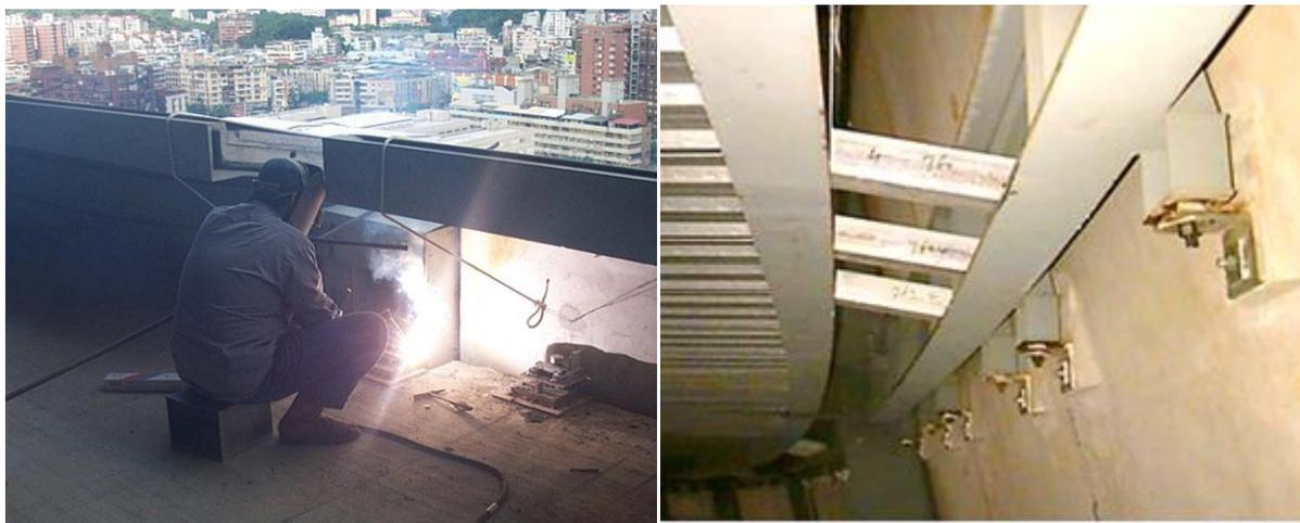
图 26 PC 外墙版结合铁件电焊或螺栓锁断固结
