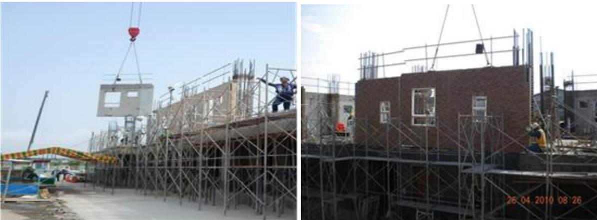
图 34 湿式 PC 外墙版起吊及安装
