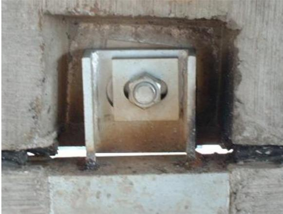
图 35 结合铁件锁定
