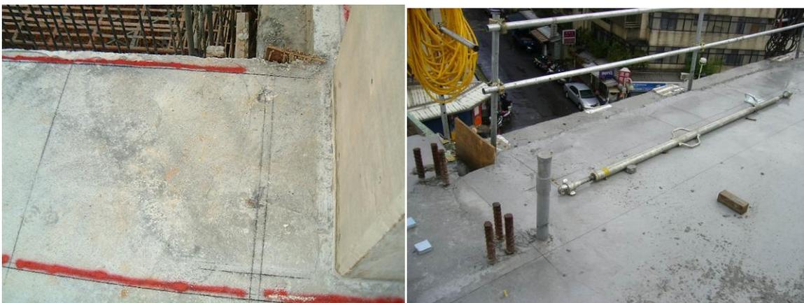
图 15 墙版分割线、铁件中心线、墙版进出线放样
