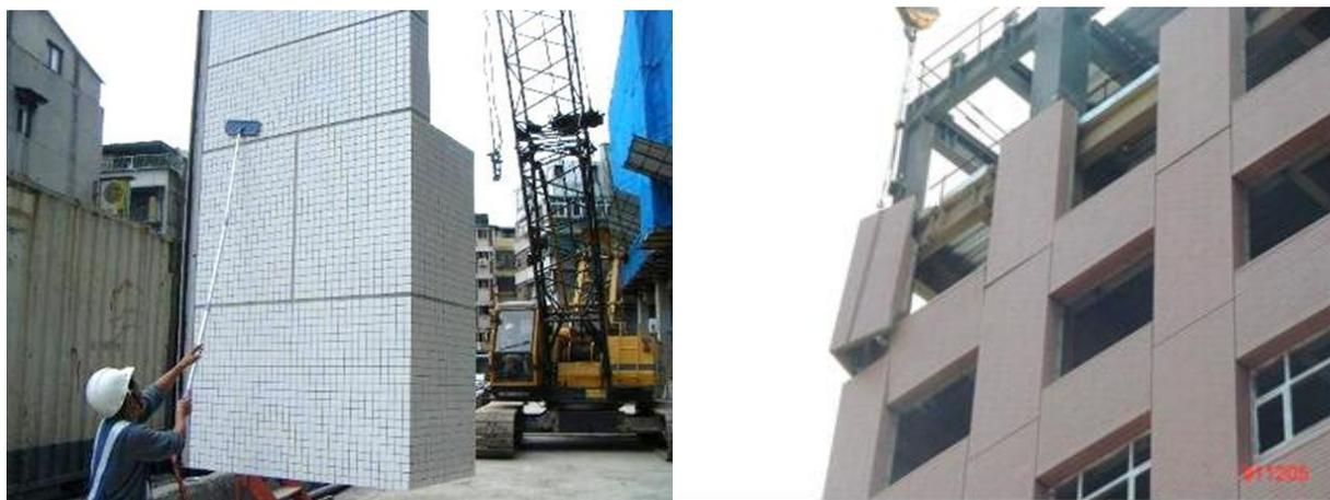
图 23 墙版安装前清洗及安装假固定
