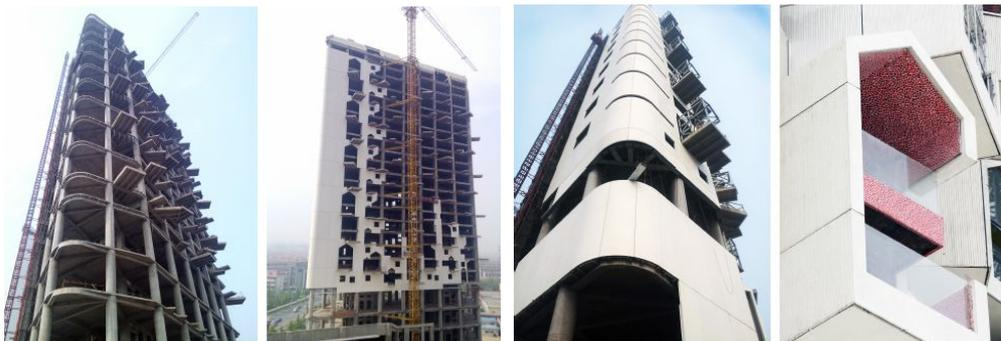
2014 年倍立达完成了著名设计大师李兴钢先生继“鸟巢”之后又一典范之作的装配式建筑——唐山第三空间。该项目位于建设北路与朝阳道交汇处，占地 1.2 万余平米。整个设计独具匠心，错层立体结构，大跨度悬挑阳台梁板，营造楼层的“空中别墅”的空间感。这种复杂的结构和造型，构件品种多，外观要求高，只有在工厂预制定型，在现场才能精准的装配，达到建筑质量与美观的统一。该建筑采用钢结构骨架，墙体外立面、楼板、阳台等构件为 GRC 预制构件。该建筑荣获中国装饰混凝土设计大赛杰出应用二等奖。
