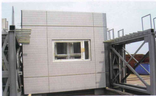
图 30 预制墙板立式储放情形
