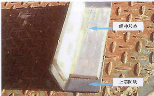
图 27 构件束紧部位加保护角铁情形
