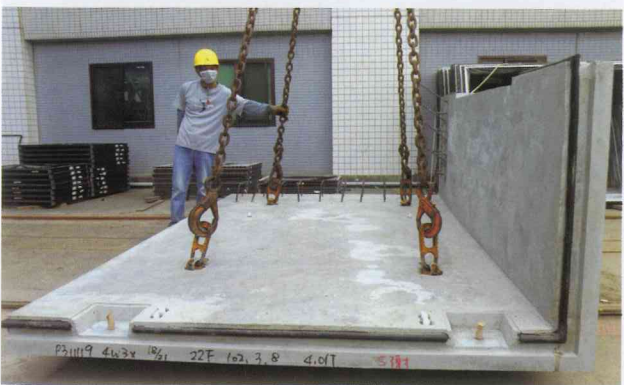
图10 墙板离地后四条吊链皆确认紧绷
