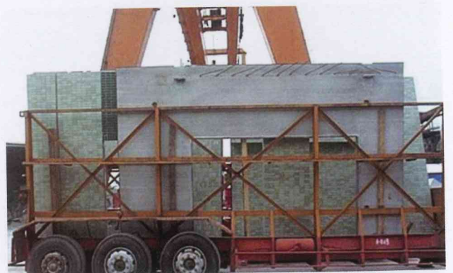
图6 低台板车装载墙板情形
