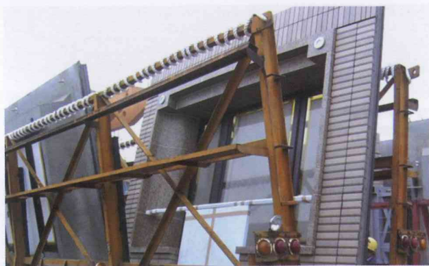
图 31 预制石材墙板立式运输情形
