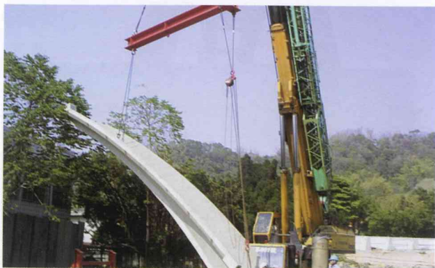
图3 轮式吊车搬运构件情形
