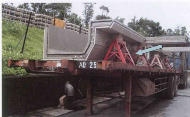
图 18 板车上构件悬臂处加稳固支撑情形
