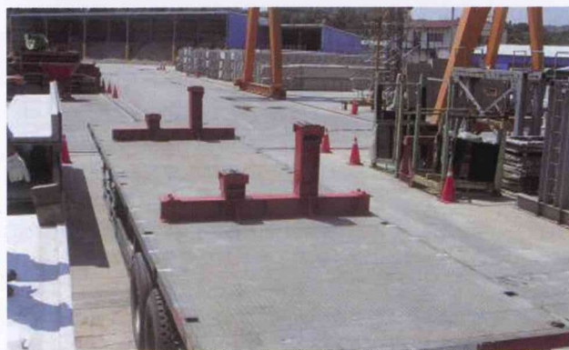
图 29 预制看台板辅以支承钢架运输情形
