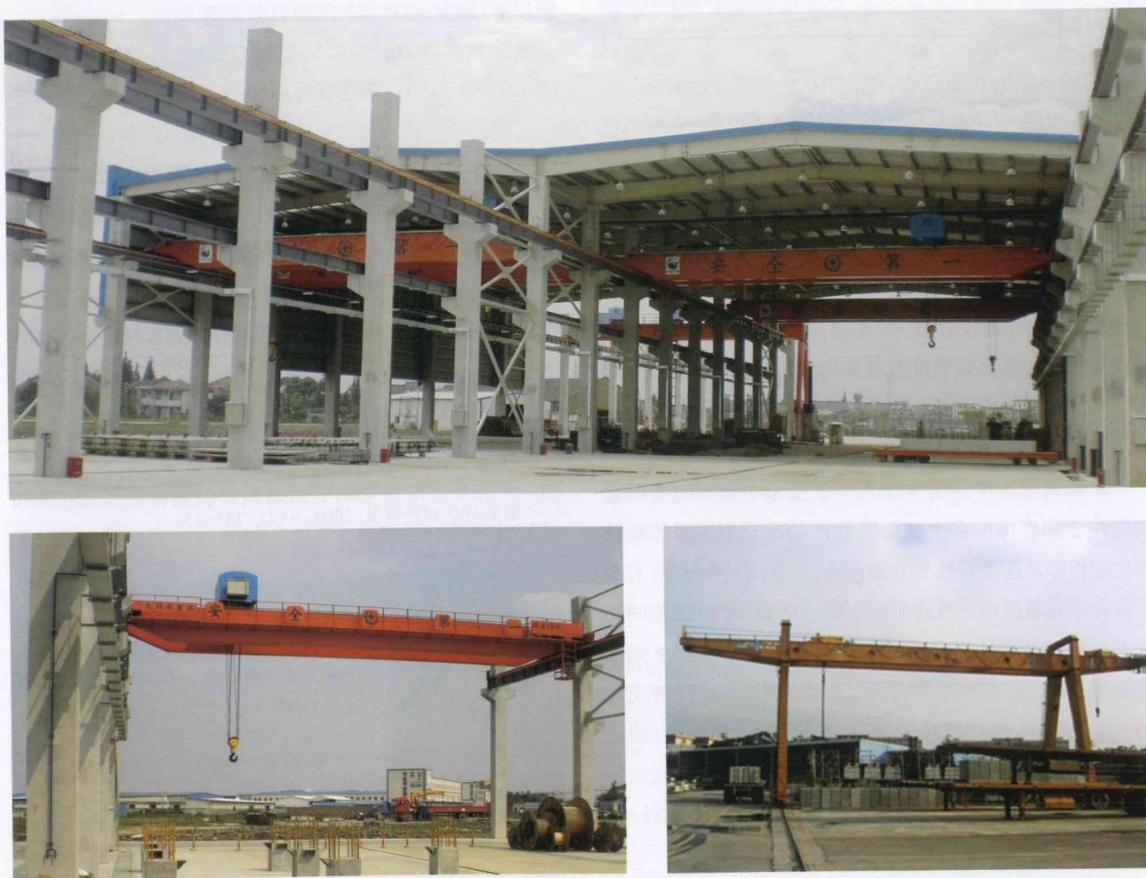
图1 钢梁桁车及门型桁车
