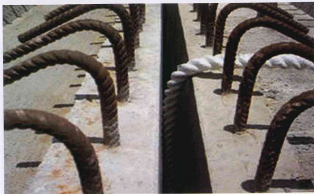
图 26 构件间用粗棉绳间隔防撞
