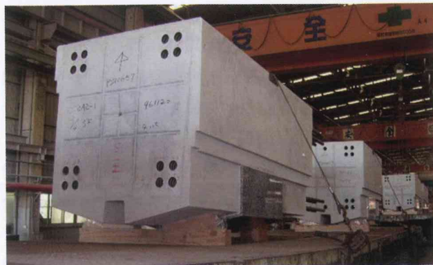
图 33 预制石材异型柱运输情形
