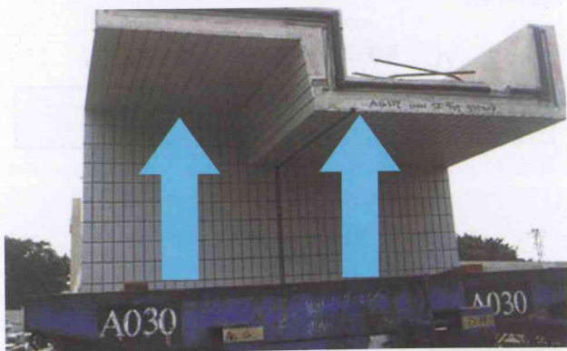
图 24 墙板错误放置未加支撑情形
