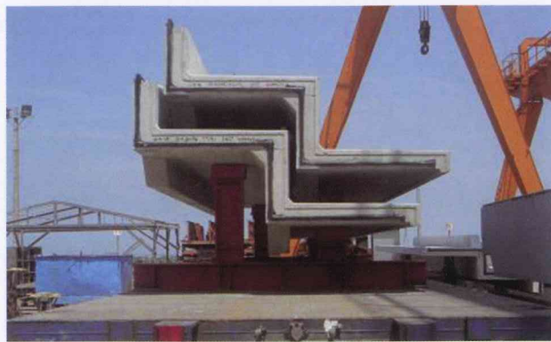
图 29 预制看台板辅以支承钢架运输情形
