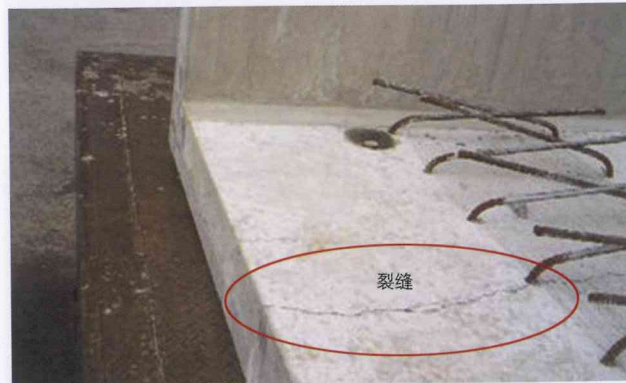
图 24 墙板错误放置未加支撑情形
