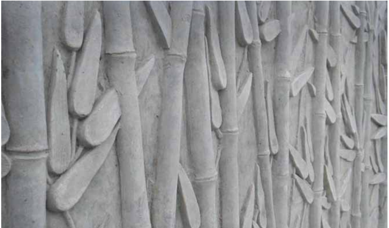
图 8 造型饰面预制外墙版外观
