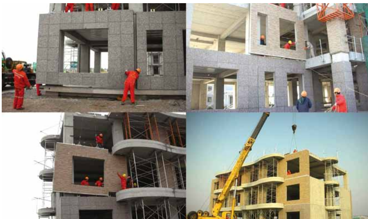
图 11 预制外墙版构件吊装施工
