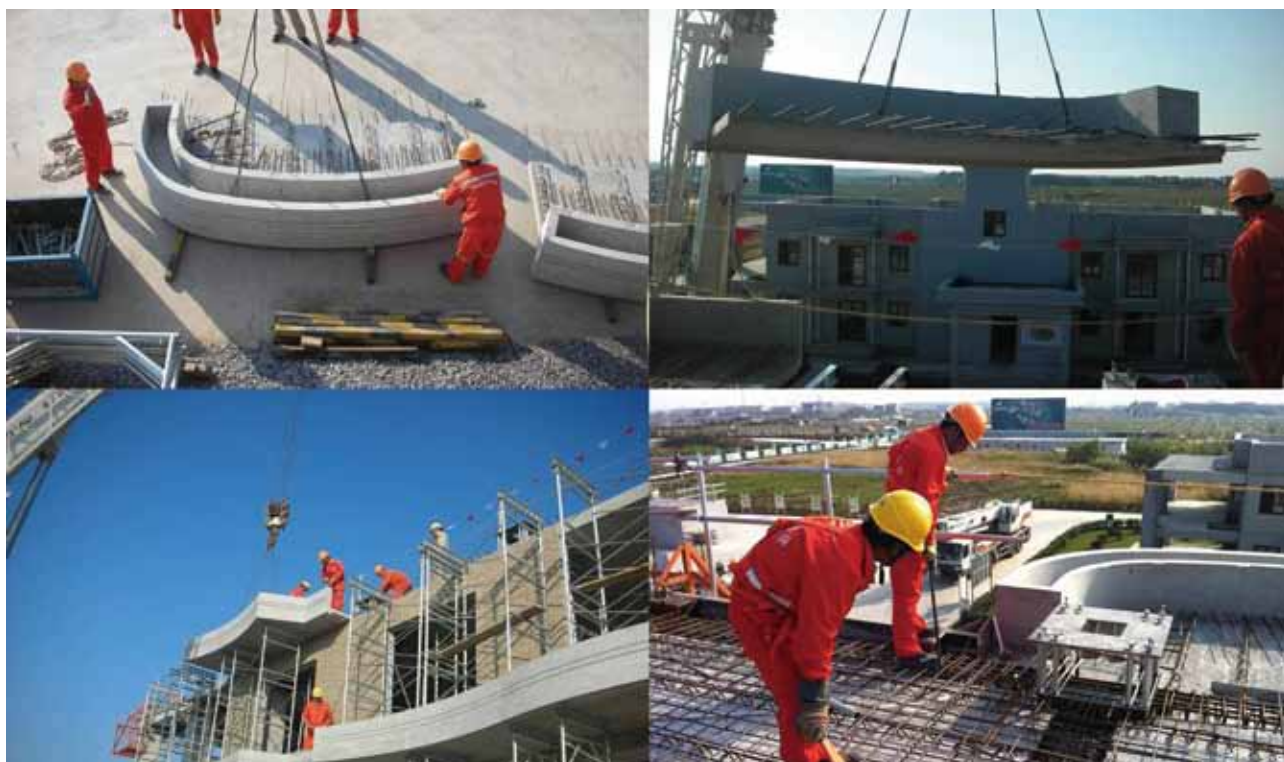
图 10 预制版构件吊装施工
