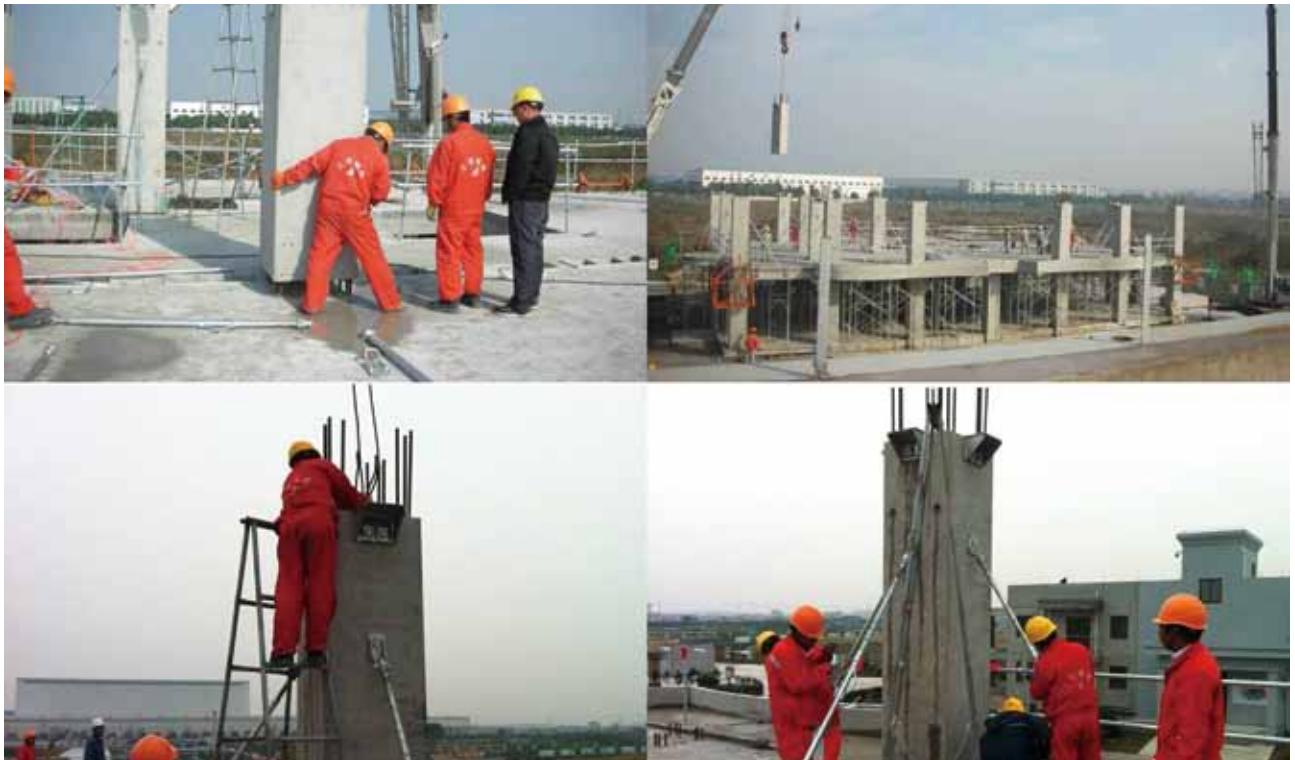
图 9 预制框架柱构件吊装施工
