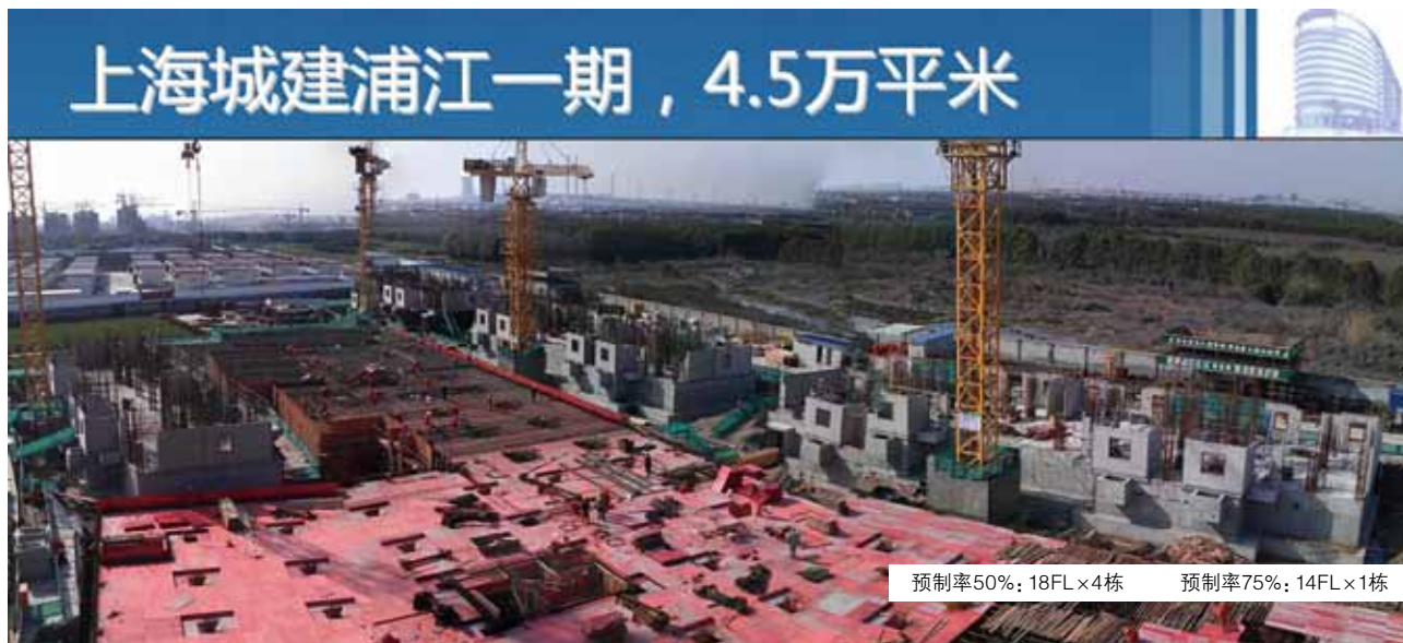
图 12 浦江保障房PC项目施工情形
