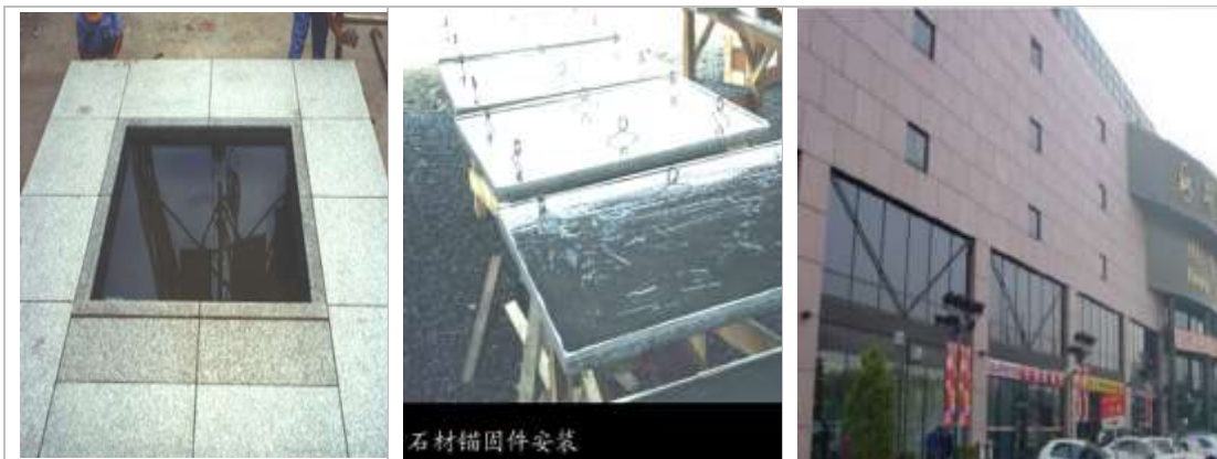
大连森茂大厦石材外墙挂板
