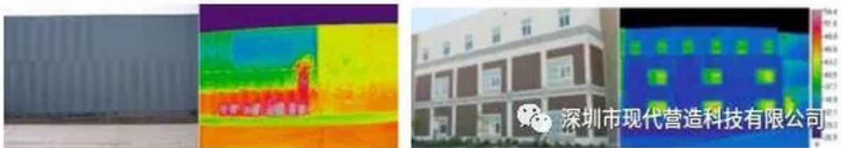
用红外摄影对比外墙的能耗（左图：普通外墙右图：用 Thermomass 制造的 TM 外墙）
