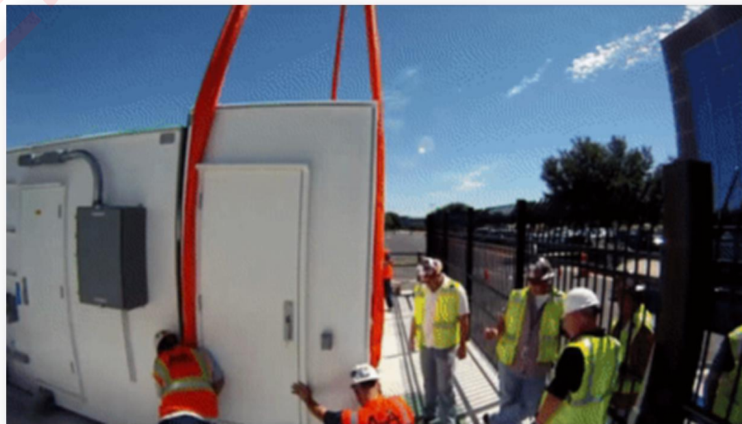
微软昆西模块化数据中心
