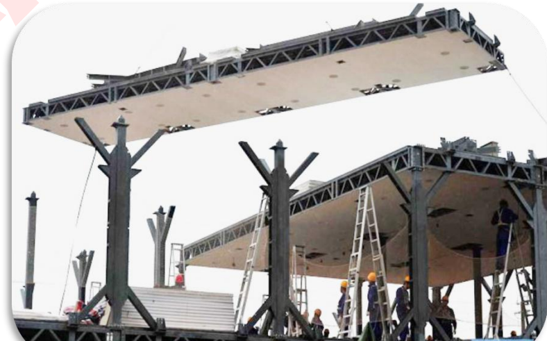
斜支撑节点钢框架体系
