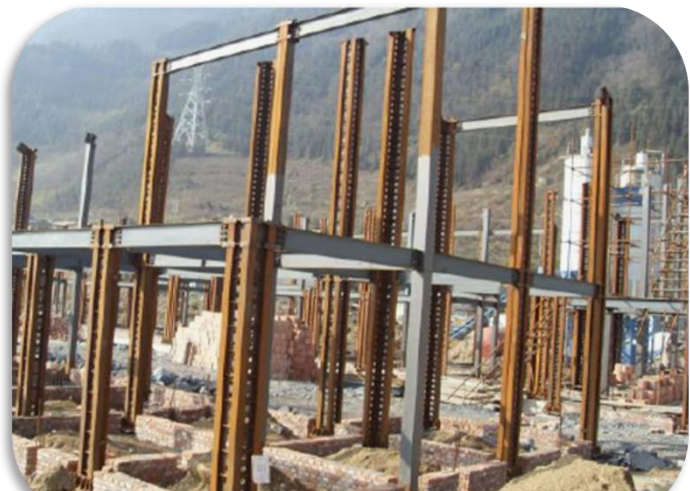
方钢管异形柱钢框架体系
