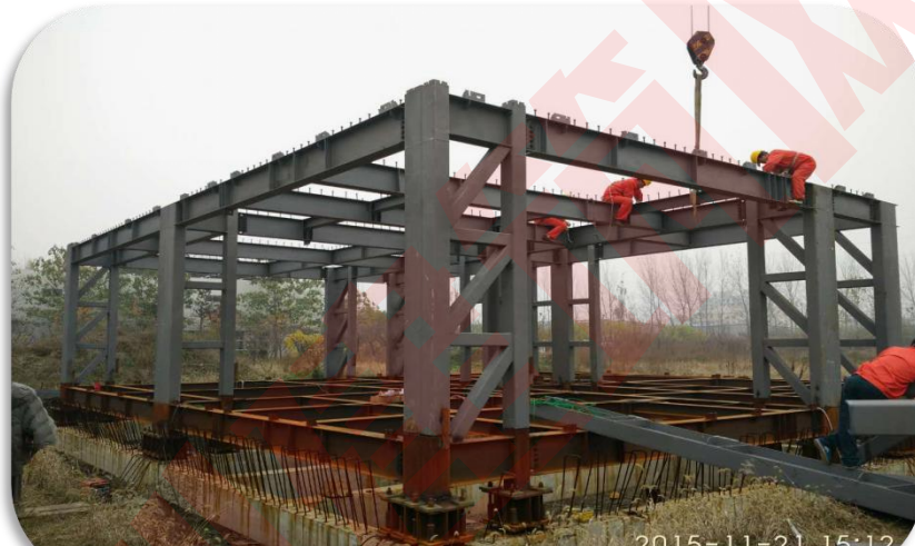
多腔柱框架支撑体系
