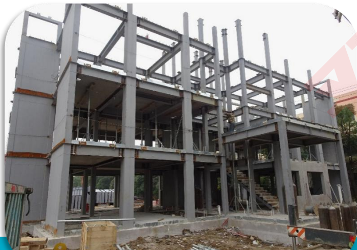
多腔柱钢框架剪力墙体系
