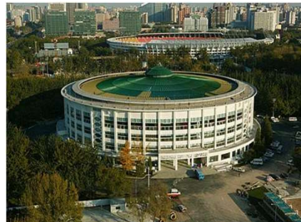
北京工人体育馆 跨度94m 1962年
