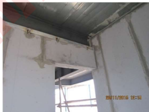
设置ALC条板过梁实景图
