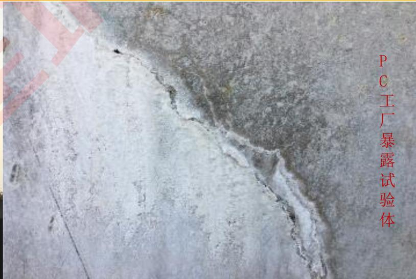
外墙上只要有0.05mm以上的贯穿缝隙，水就能通过毛细管现象及重力的自然现象侵入到室内
