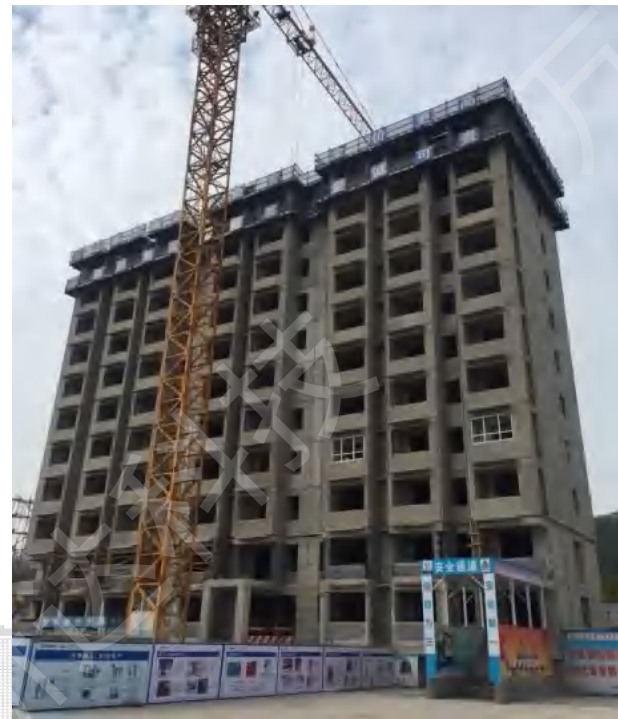
港新园3#楼施工照片
