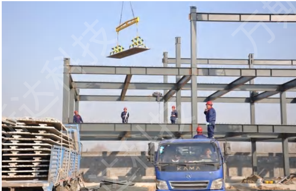
专用吊具——吊装PK板
