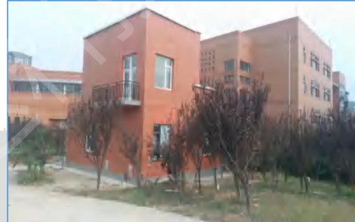
山建大被动式实验楼
