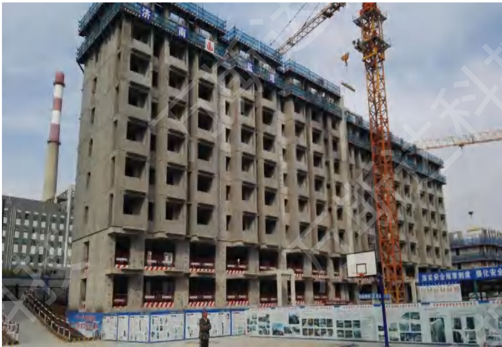
港新园2#楼施工照片
