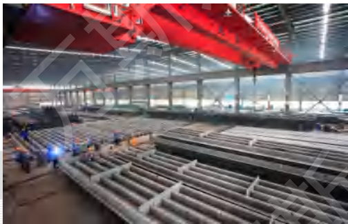
钢箱梁生产现场照片
