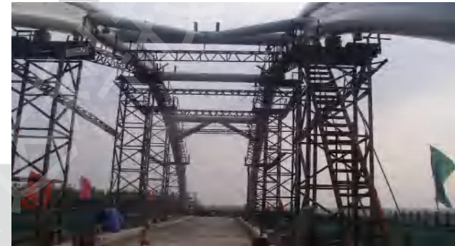
海青铁路跨潍胶公路特大桥 (2012)
