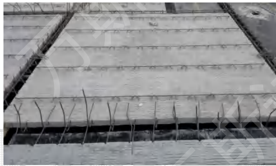
钢筋桁架混凝土叠合板
