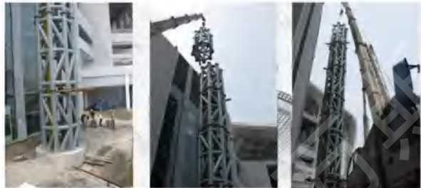
火炬塔安装过程 (2009)
